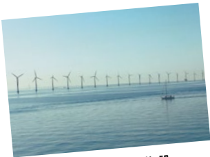
洋上風力発電施設 (デンマーク)
