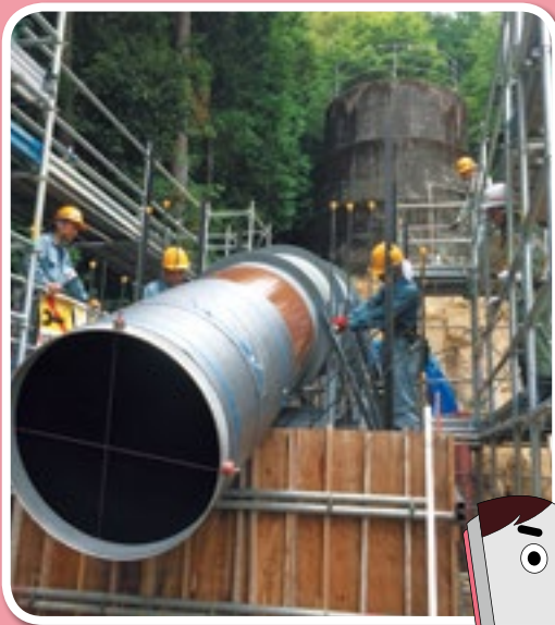
▲ 水圧鉄管の取り替え工事の様子
