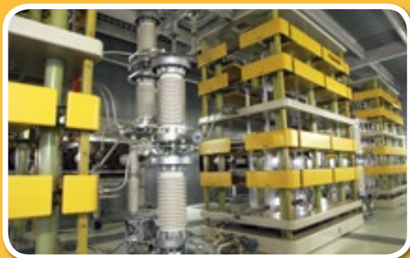
▲ 交直変換器/周波数変換所の機器の一つ。交流と直流の変換を行う
