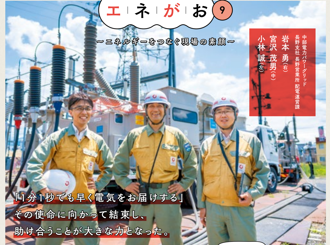
撮影場所 / 長野県 豊野変電所
