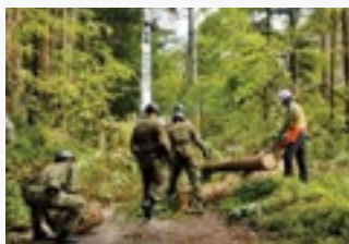
自衛隊と連携した倒木などの撤去作業
