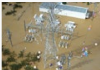
豊野変電所(長野市豊野町)
